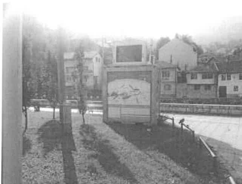
Slika 2. Automatska stanica "Vijećnica"
