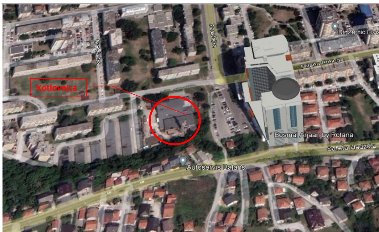
Slika 2. Uža lokacija objekta
