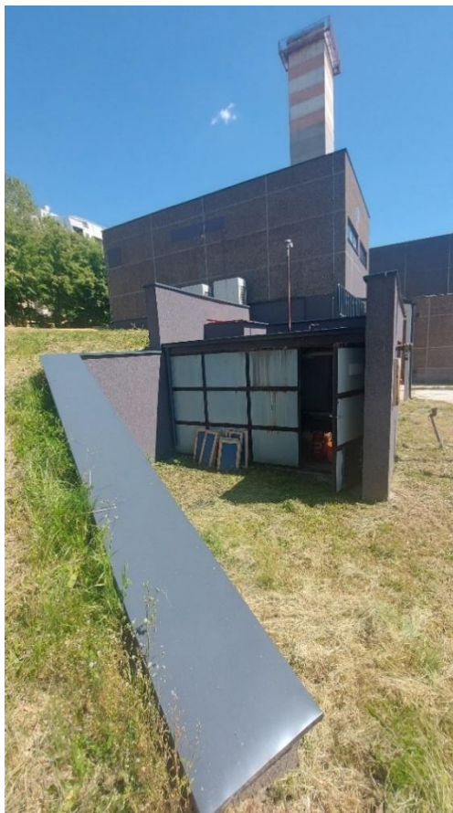
Slika 2. Objekat sa rezervoarom lož ulja
