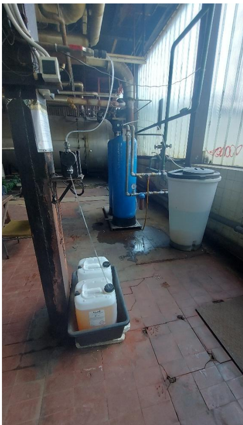
Slika 14. Ionski izmjenjivači
