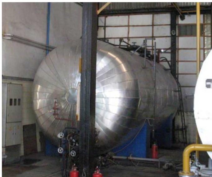
Slika 9. Dnevni spremnik goriva koji nije u funkciji
