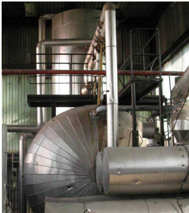
Slika 12. Napojni spremnik sa otplinjivačem
