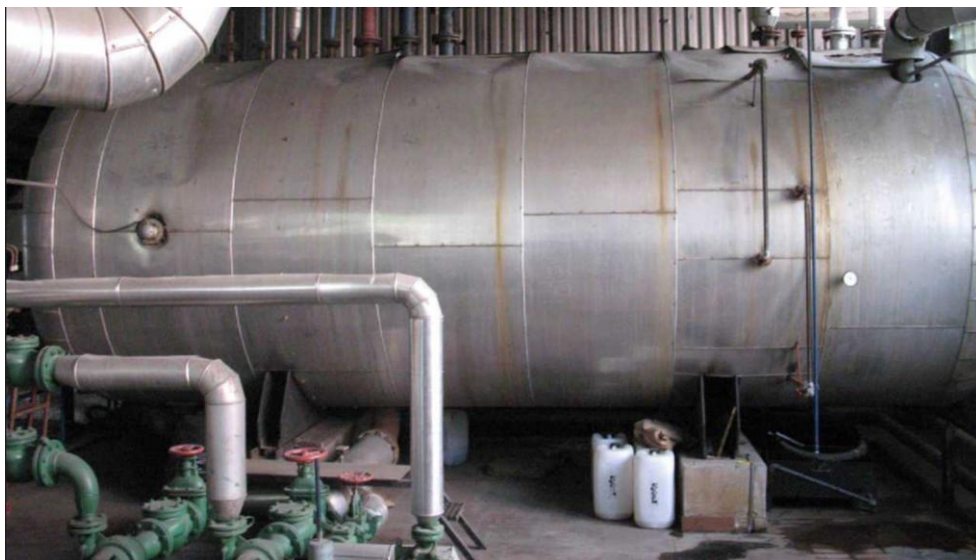
Slika 13. Rezervoar kondenzata
