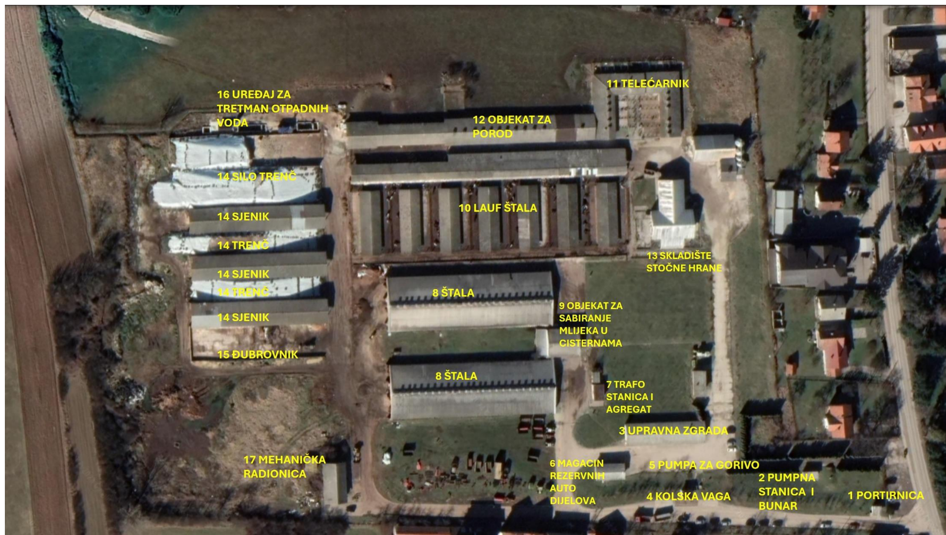
Slika 3. Prikaz lokacije sa ucrtanim objektima
