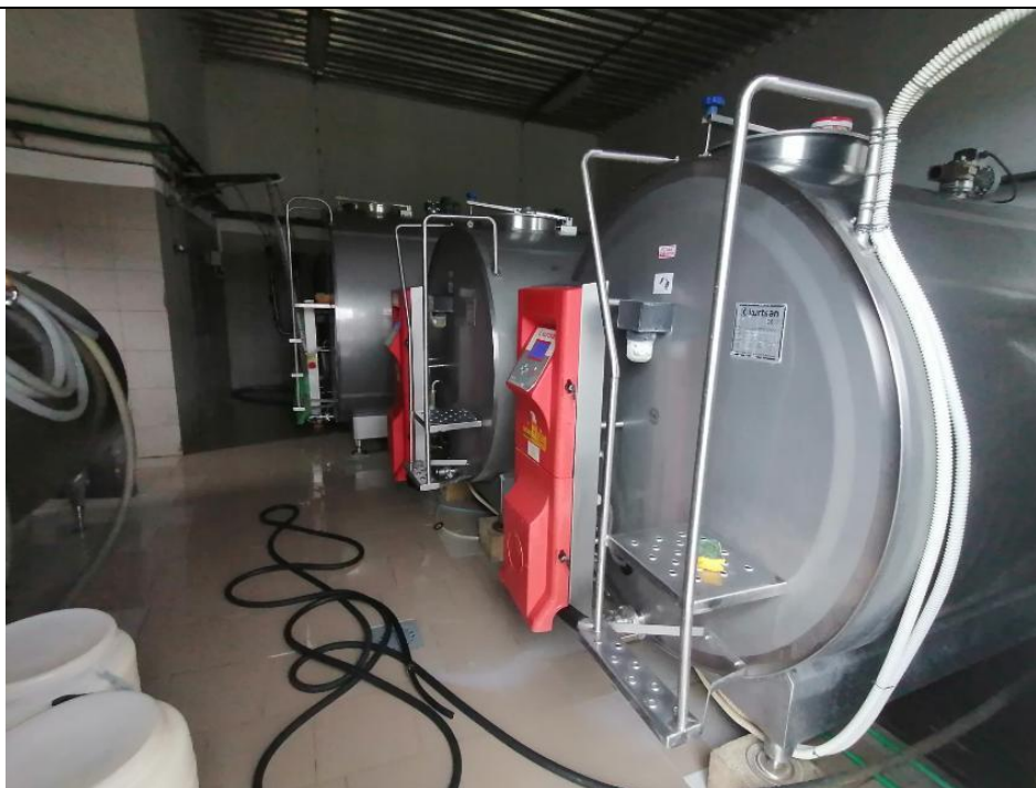
Slika 8. Objekat za sabiranje mlijeka u cisternama - prihvatna mljekara
