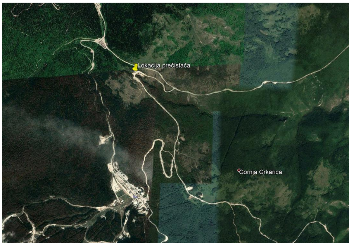
Slika br. 6. Satelitski snimak lokacije na kojoj izgrađeno postrojenje za prečišćavanje otpadnih voda – I faza
