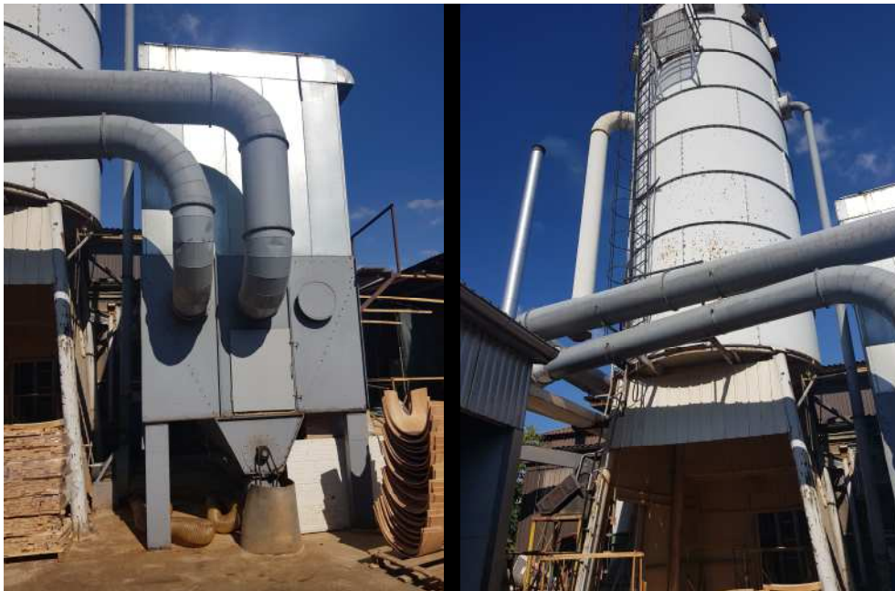
Ciklon i silos
